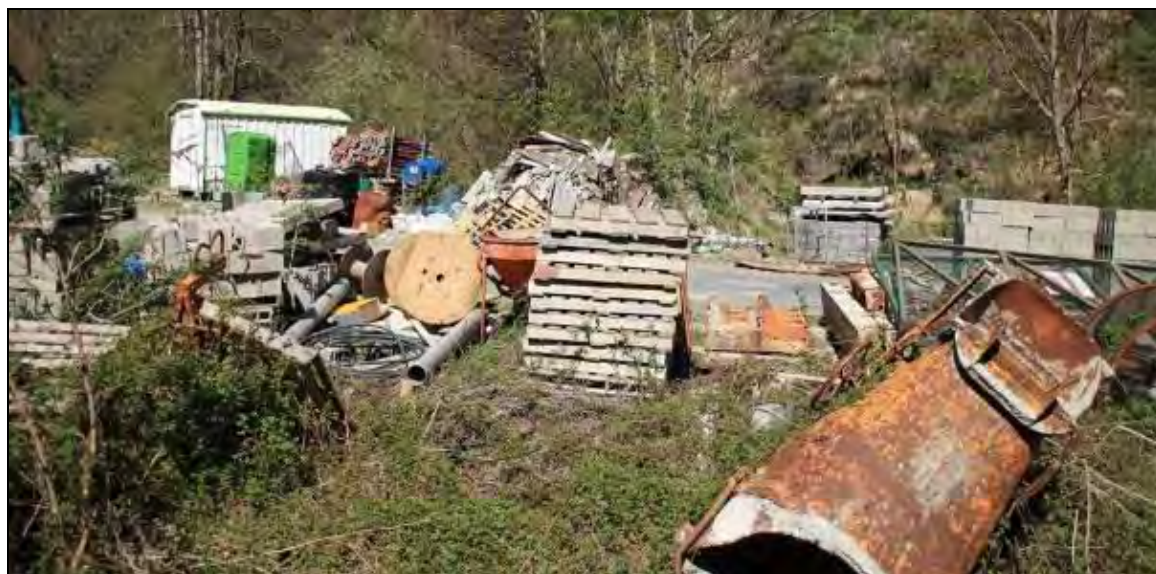
Déchets divers, entre la D 920 et le Gave de Cauterets, parcelle AB 198 a © ETEN Environnement
