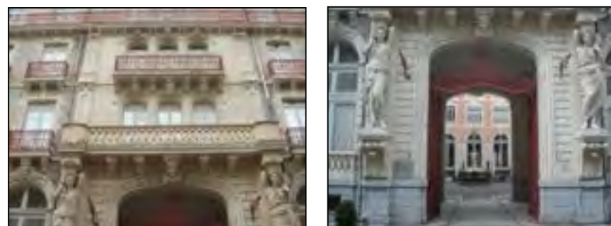
Détail de la façade de l'Hôtel Continental
