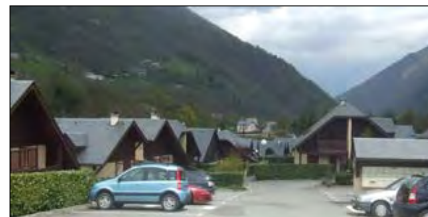
Opération d'ensemble, secteur Pont de Fanlou
